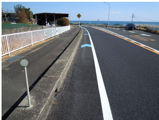
写真 車道混在(歩道あり)の整備状況(紀宝 BP)
